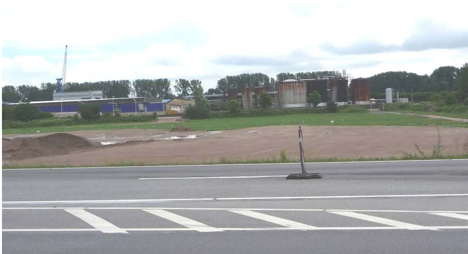
Hier soll die neue Brücke die Bundesstraße überqueren. Das Bild zeigt die Brachflächen und das Industriegelände im Bereich des Flussufers.
